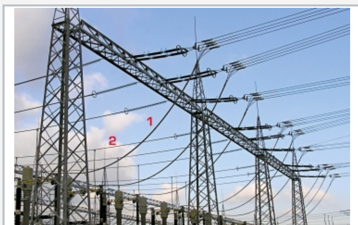
Cables suspendidos en un caso real (pórtico de arriostramiento): 1 cable de arriostramiento, 2 línea eléctrica, similar a una línea de transporte a larga distancia
