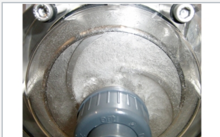
Formation de bulles de vapeur sous l'effet de la cavitation sur la roue de pompe
