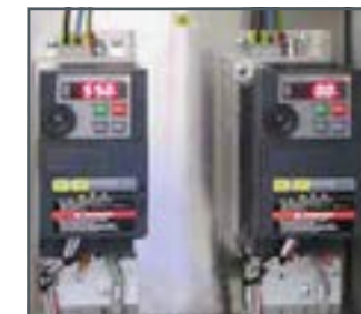
Convertisseurs de fréquence pour contrôler les pompes
