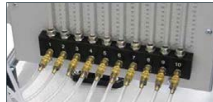
Connexions sur le tableau des manomètres pour mesurer le cours de la pression dans le lit filtrant
