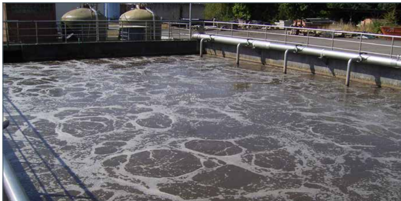
Étape de traitement biologique dans une station d'épuration (bassin d'aération)
