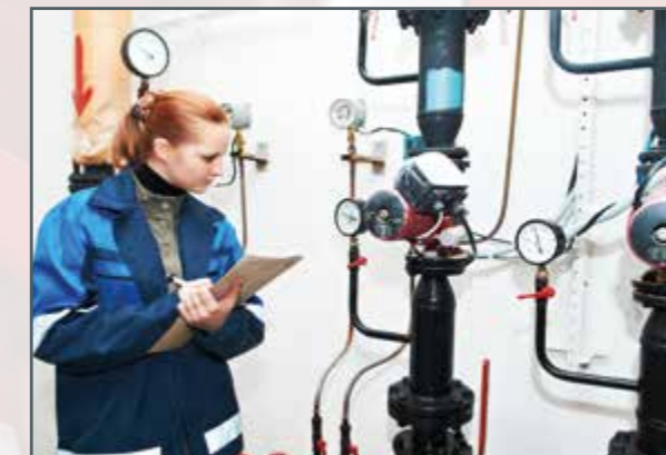
Contrôle des composants de l'installation
