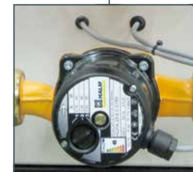
Pompe de circulation non régulée avec vitesse de rotation réglable (classe d'efficacité C)
