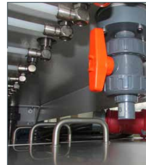
Points de mesure de la pression et robinet de vidange
