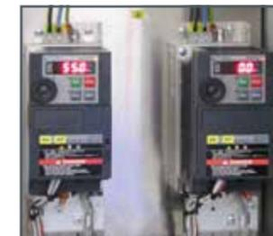
Frequenzumrichter zur Steuerung der Pumpen
