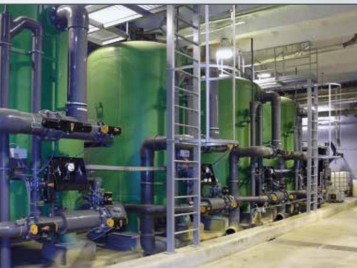
Kontinuierlich durchströmte Adsorber in einer Wasserbehandlungsanlage
