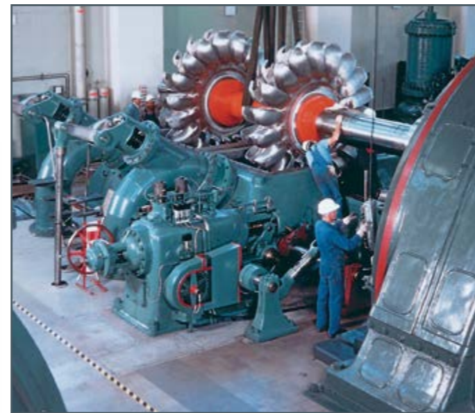
Montage d'une turbine Pelton dans la centrale électrique de Walchensee, Allemagne (Voith Siemens Hydro Power)
