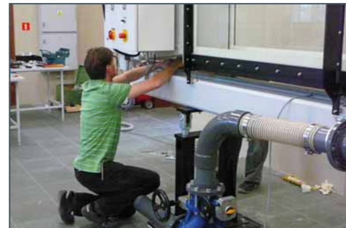
Derniers travaux sur l'installation électrique (à gauche). Le réservoir d'eau est ensuite aligné et relié au système de tuyauterie (à droite).
