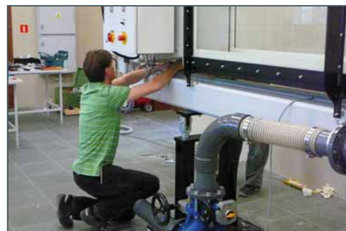
Letzte Arbeiten an der elektrischen Installation (links). Danach wird der Wasserbehälter ausgerichtet und mit dem Rohrleitungssystem verbunden (rechts).
