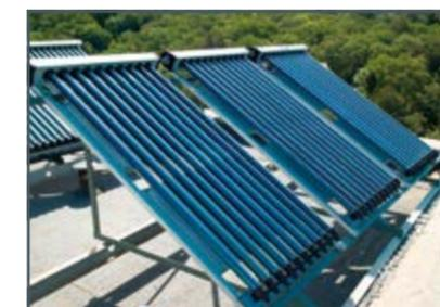
Capteurs à tubes montés avec un angle d'attaque optimisé sur un toit plat
