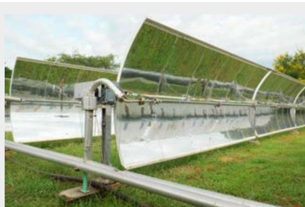
Für ein Kraftwerk können einzelne Parabolrinnenkollektoren in einem Kollektorfeld zusammengeschaltet werden.
