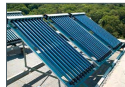
Colectores tubulares montados en un tejado plano con un ángulo de ataque optimizado
