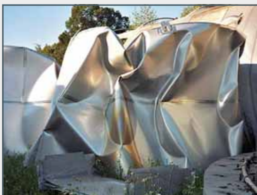
Écroulement du réservoir suite à un coup de bélier
