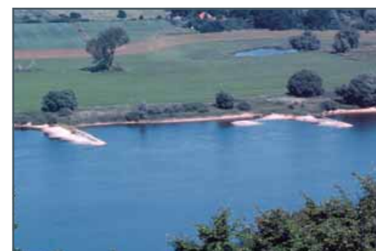
Dépôt de sédiments sur des épis de rivière
