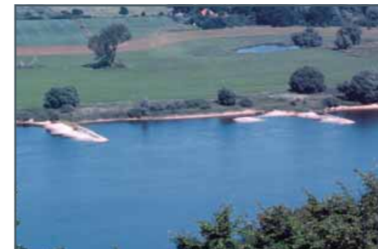
Sedimentablagerung an Flussbuhnen
