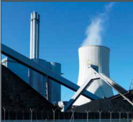
Centrale à charbon
