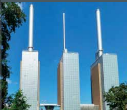
Centrale thermique à turbines au gaz et à vapeur
